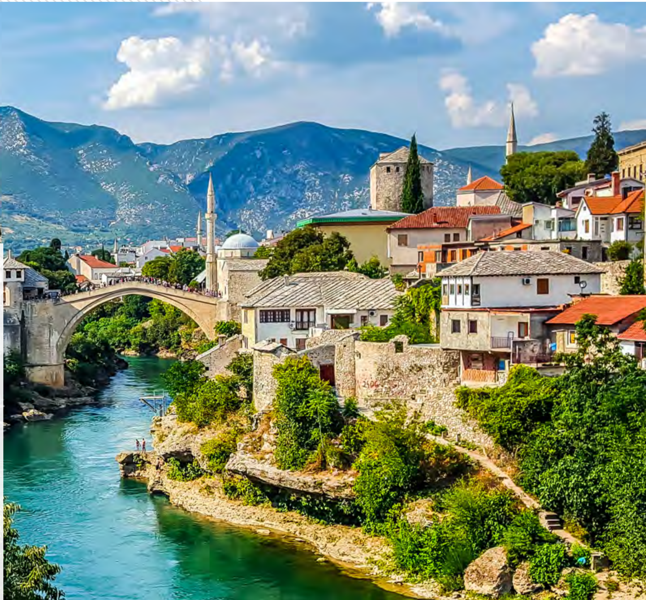
Старый мост в г. Мостар
